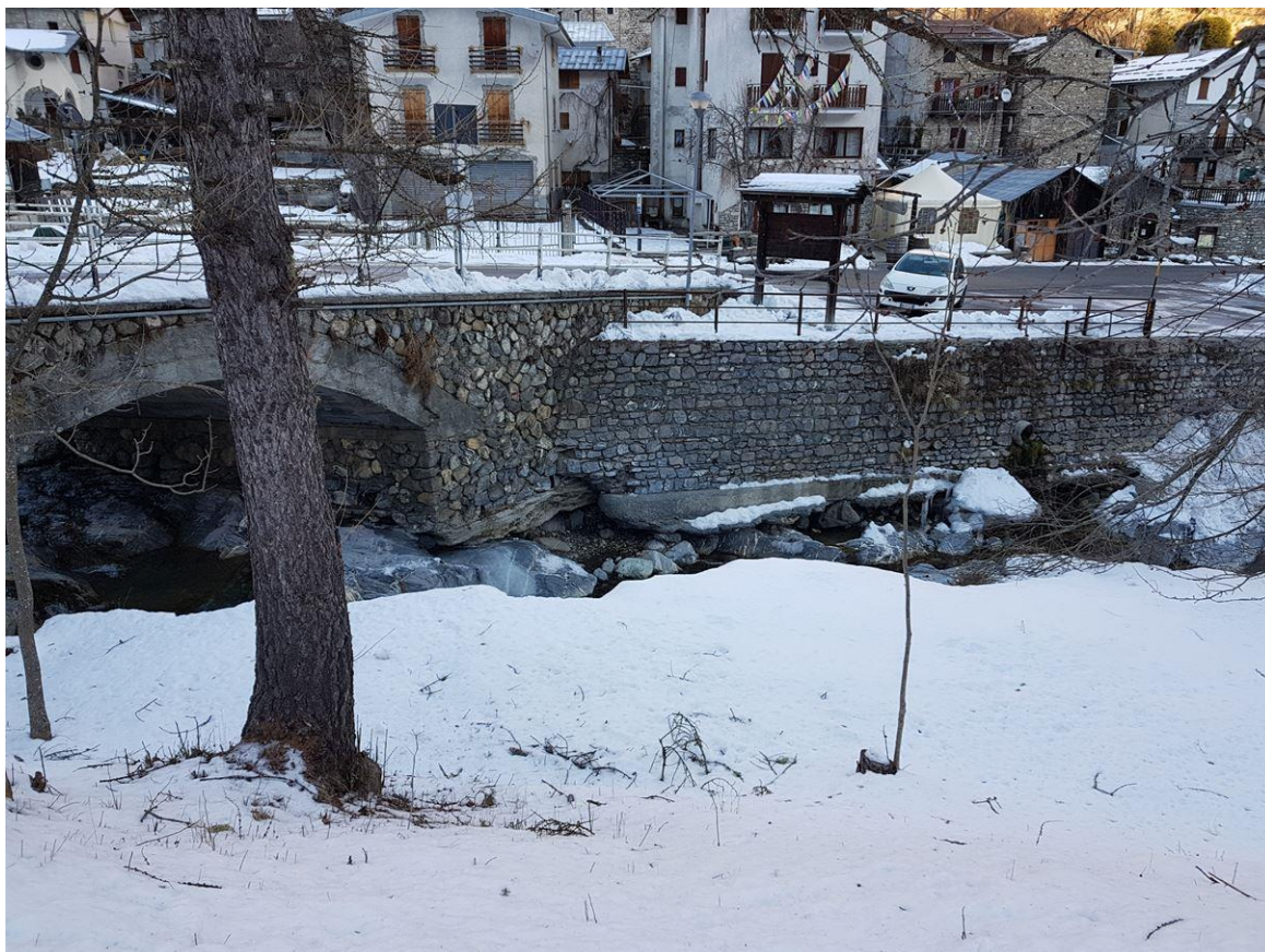
Immagine 9: primo tratto di muro di difesa spondale posto in sinistra orografica a valle del ponte da sottomurare
