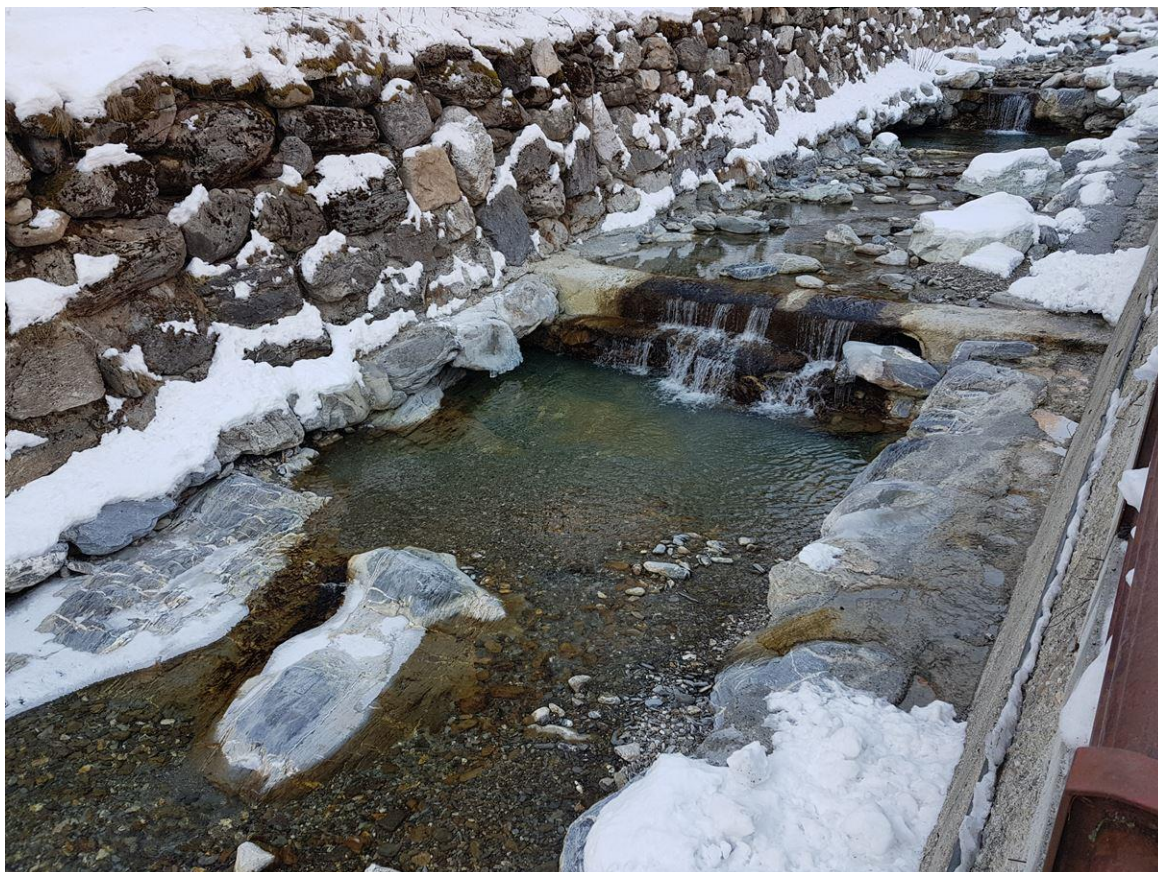
Immagine 5: fraz. Upega, salto di fondo n.6 a valle della confluenza tra torrente Negrone e rio Snigg – sottomurazioni scalzamenti e ripristini
