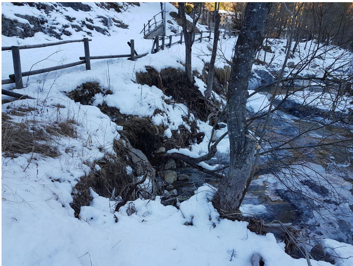
Immagine 11: primo tratto di scogliera in sinistra orografica del rio Corvo da ripristinare
