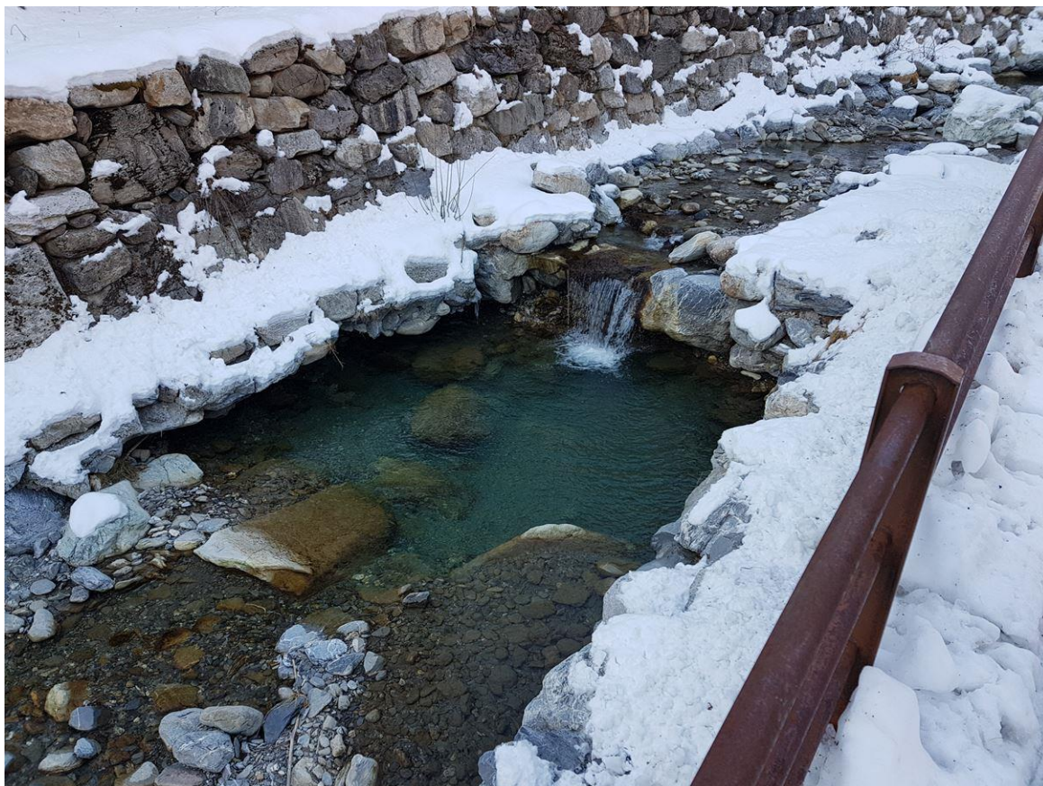
Immagine 4: fraz. Upega, salto di fondo n.5 a valle della confluenza tra torrente Negrone e rio Snigg – sottomurazioni scalzamenti e ripristini
