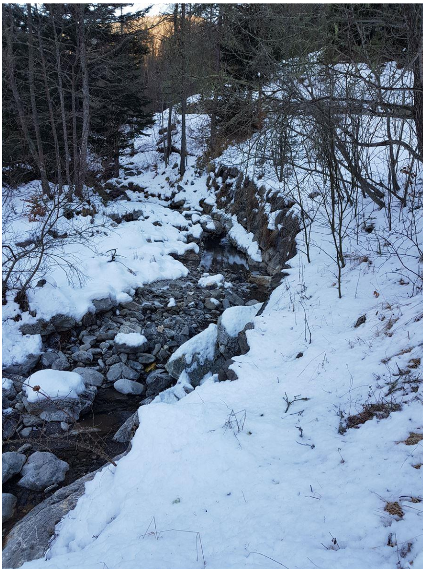
Immagine 13: tratto di scogliera in sinistra orografica del rio Corvo da proteggere con dado anti-scalzamento in massi ciclopici
