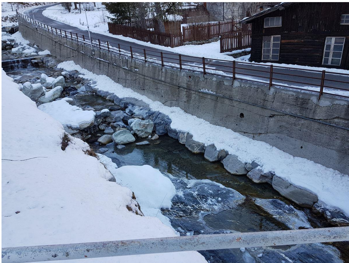
Immagine 8: fraz. Upega, dado di protezione anti-scalzamento in sponda sinistra del torrente Negrone a monte del ponte
