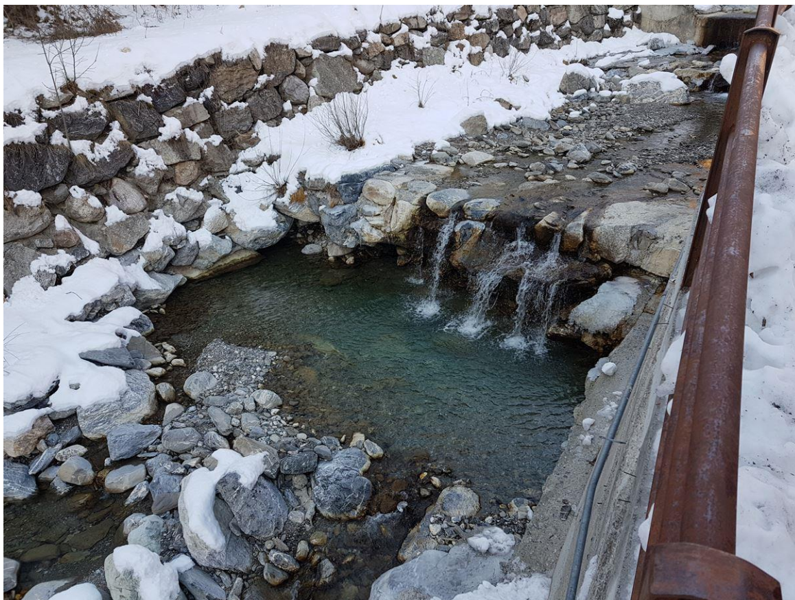
Immagine 3: fraz. Upega, salto di fondo n.4 a valle della confluenza tra torrente Negrone e rio Snigg – sottomurazioni scalzamenti e ripristini
