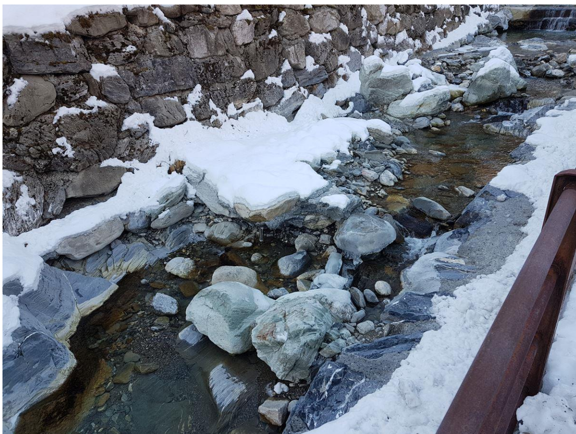
Immagine 6: fraz. Upega, salto di fondo n.7 a valle della confluenza tra torrente Negrone e rio Snigg – sottomurazioni scalzamenti e ripristini
